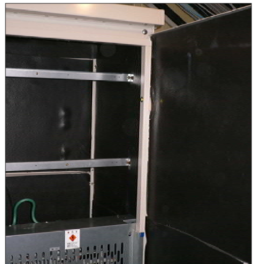
扉へ防音材を貼付け
