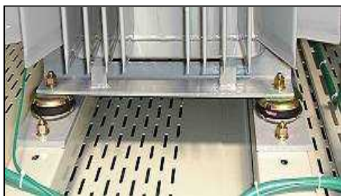
変圧器に防振ゴム取付
