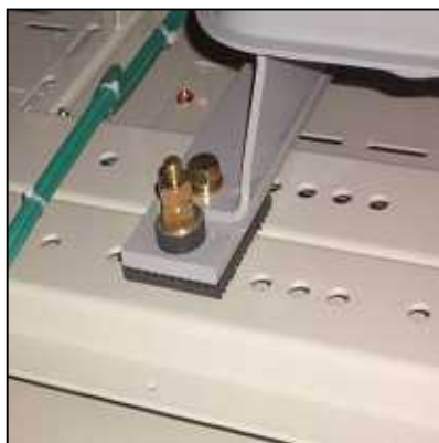
変圧器に防振パッド取付
