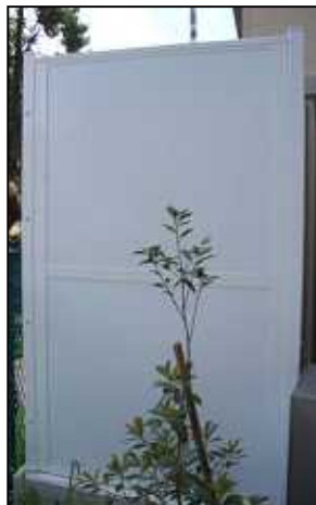
隣への隣接面に防音壁取付
