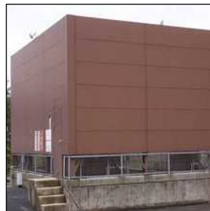
全体を防音壁で囲った例
