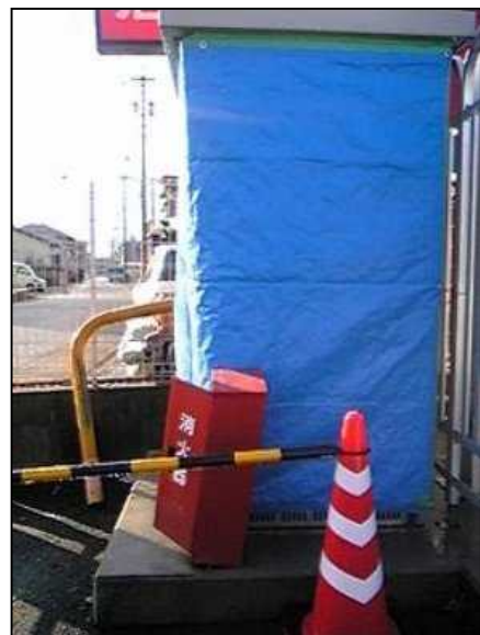
保安協会により電気復旧とともにキュービクルは養生し、後日入替
