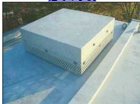
現地でパンチング加工した鋼板を SUS製ボルトで側面に固定
